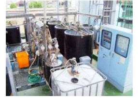
全自動排水処理施設(自社設計施工)
