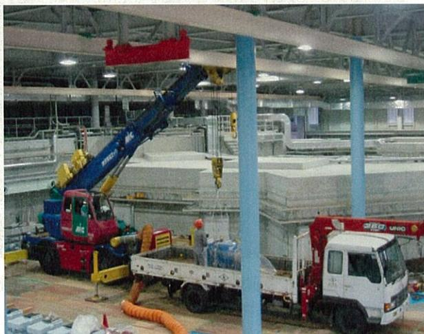
図 1 偏向電磁石搬入状況(2003 年 10 月)。トラックの荷台にあるのが偏向電磁石。実験ホールに直接、トラックとクレーンを乗り入れ、重さ約 4t の偏向電磁石 16 台を蓄積リング遮蔽壁そばに下ろした後、コロ引きでリング内最も奥から順次に搬入設置した。
