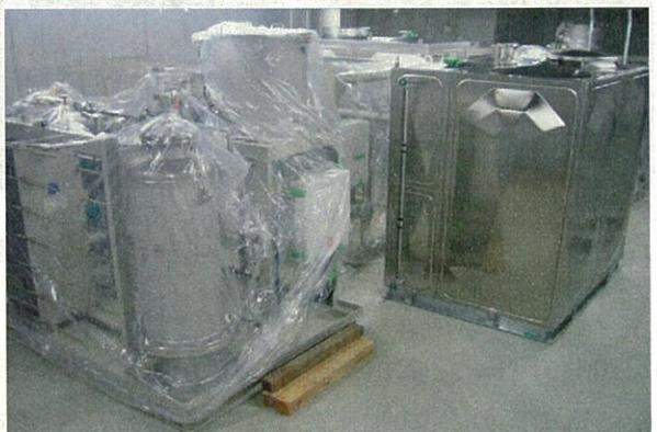
図 3 設置中の冷却水系の状況(2003 年 9 月)。左側ビニールシートに覆われたものが蓄積リング電磁石冷却系、右側は蓄積リング高周波空洞冷却系。
