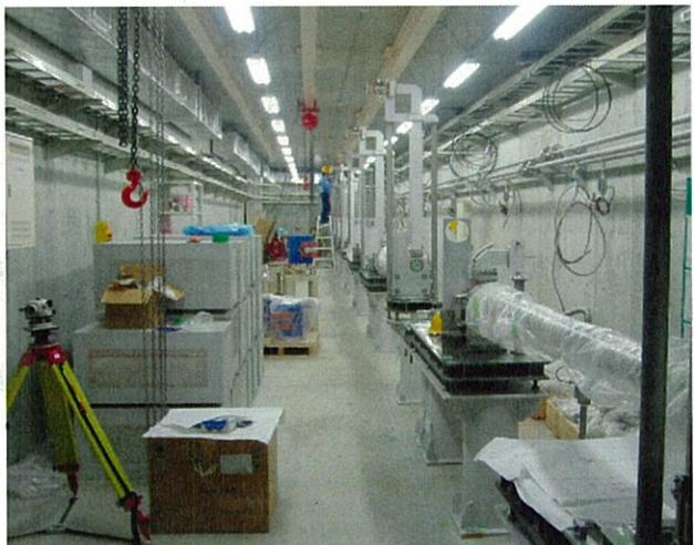
図6 リニアック設置作業中のリニアック室。(2004年6月)。バンチャーセクション出口から下流を撮影。加速管(AT1)が既に設置されている。
