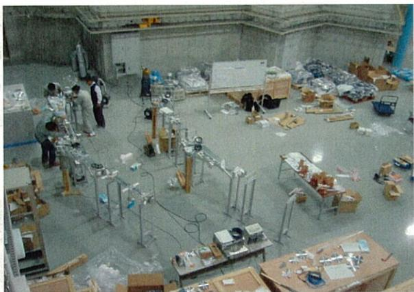
図4 リング真空チャンバープレベークの状況(2004年1月)。実験ホールで2セル分の真空チャンバーを仮組みし、プレベークを行った。
