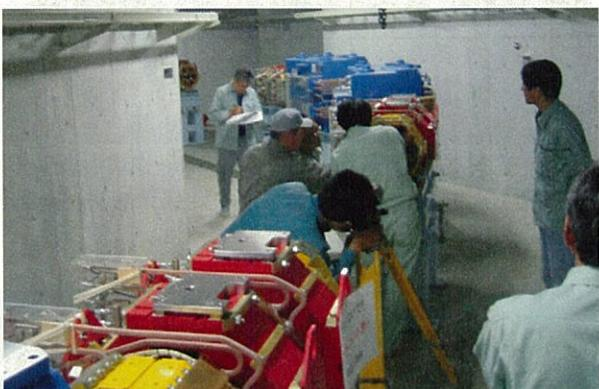
図 2 マグネットアライメント。レーザートラッカー、測量器等を用いて設置精度 $\pm 200 \mu\text{m}$ で行った(2003 年 10 月)。
