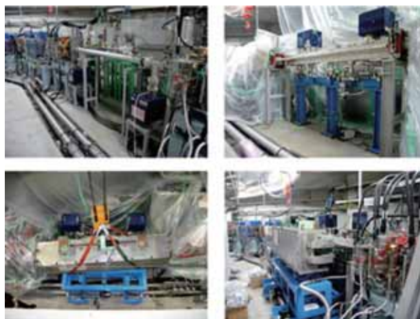
図8 アンジュレーター導入時の作業
