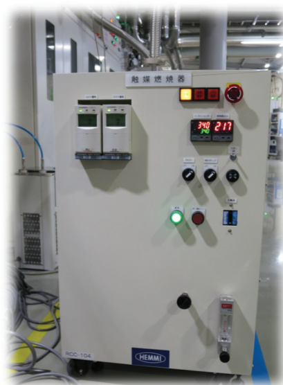
図5 導入した触媒燃焼器の外観
