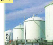
大型貯蔵タンク断熱材
